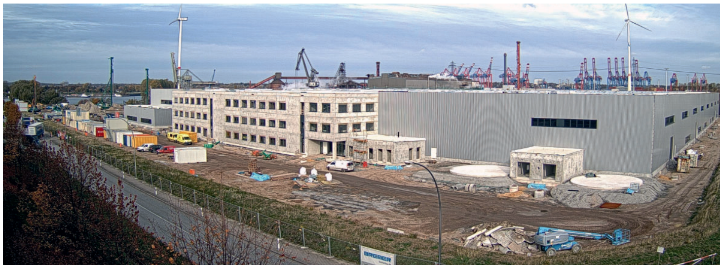
Die Baustelle am Genter Ufer Mitte November
