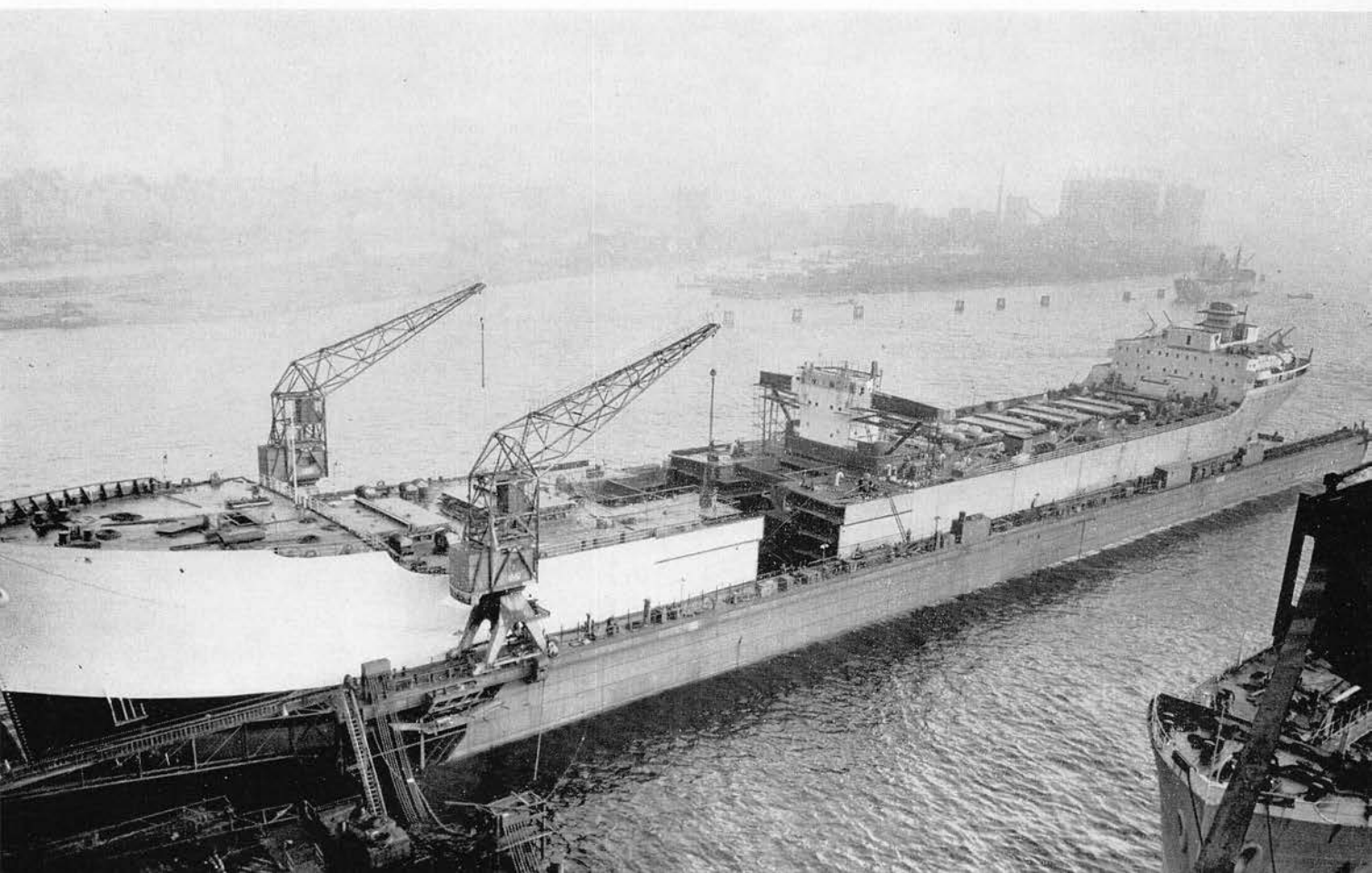
Die Bauteile werden im Dock zusammengefügt
