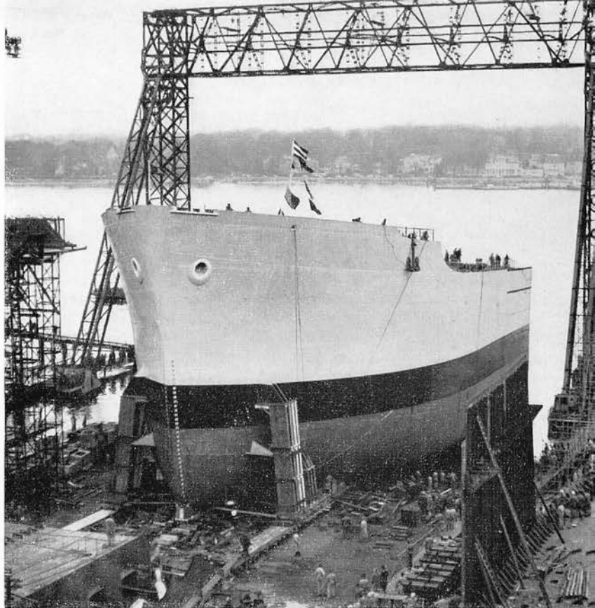
Stapellauf des Vorschiffs Bau-Nr. 711
