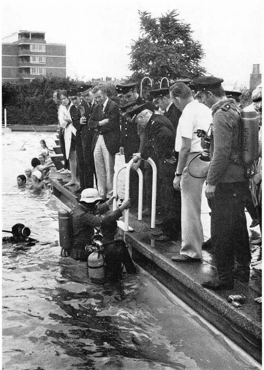
Die Tauchversuche mit dem schweren Atemschutzgerät (Preßluftatmer DA 58/1600) zeigten, daß ein mit diesem Gerät ins Wasser gestürzter und unter Wasser geratener Feuerwehrmann so lange handlungsfähig bleibt, als er selbst atmet.
