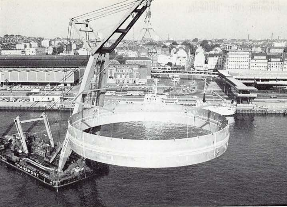
Zu den Fotos: „Hebe 1“ hat Zone 4 aus der Baulehre gehoben und setzt sie auf Zone 3. Vier Hellingkrane beim Aufnehmen der Sektion A.
