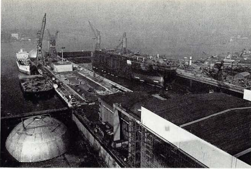
Das am 20. Februar 1976 aus dem alten Dock 8 in das neue Großdock umgeschwommene Teilschiff Baunummer 85 wurde am 21. Februar im Dock 8 a abgesetzt.
