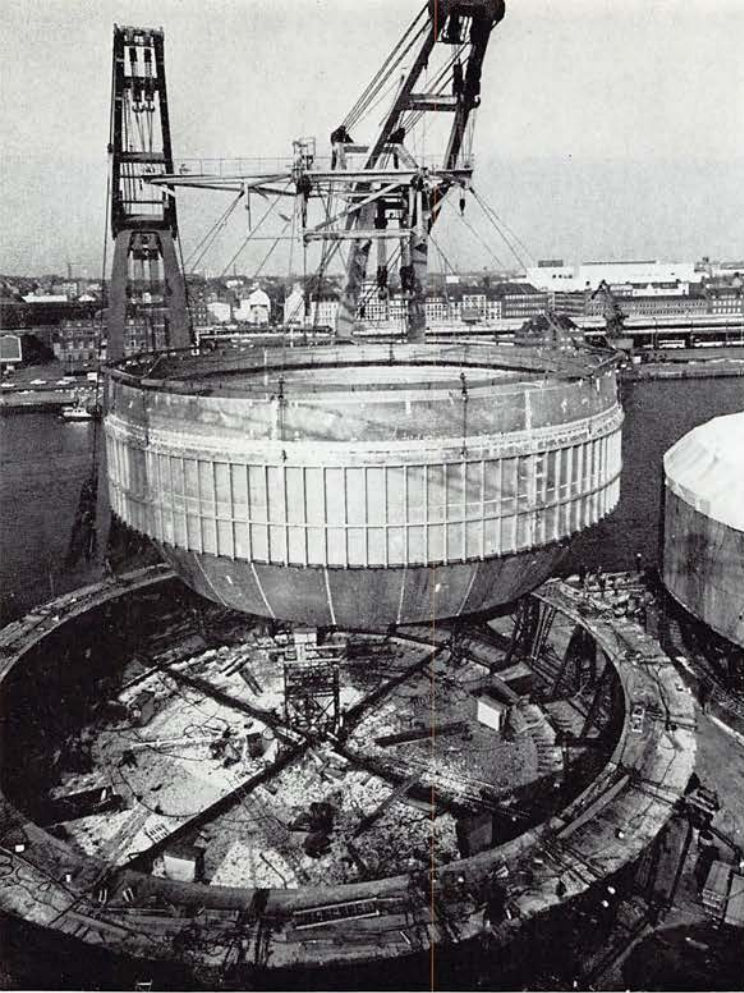
11. 3. 76: Die Schwimmkräne „HEBE 1“ und „ENAK“ transportieren die Sektion B3 vom Werk Süd zum Dock 7.
