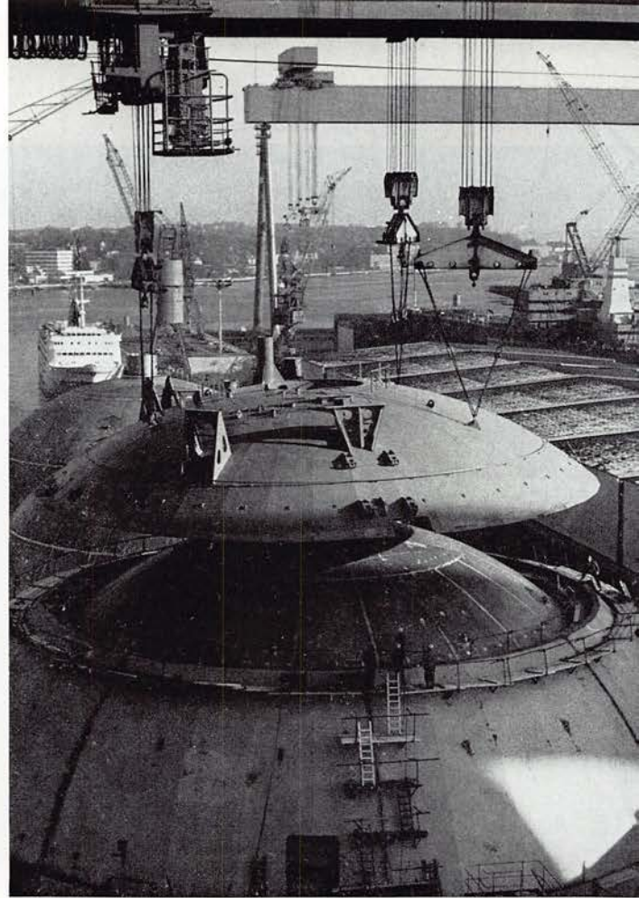
12. 4. 76: Mit dem Transport der Kalotte wird die Montage der Abdeckhaube des Lade-tanks 5 abgeschlossen.
