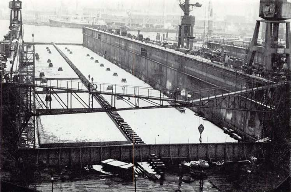
Das für die Eindockung der „DRUPA“ hergerichtete Dock 21. Vorn und achtern sind die Abschottungen zu erkennen; links im Vordergrund eine zusätzliche „Ölwanne“ aus einer 600 mm hohen Blechwand.
