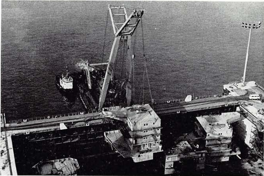
Am 23. Februar setzte ein Schwimmkran in Dietrichsdorf vorgefertigte Deckshaussektionen hinter dem Docktor im Dock 8 a ab, ...
